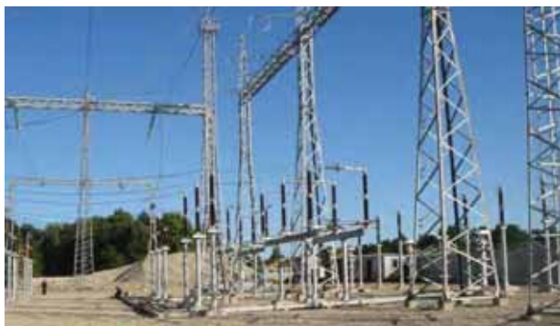
Строительство заходов ВЛ 110 кВ на ПС 220/110/35 кВ АМЕТ
