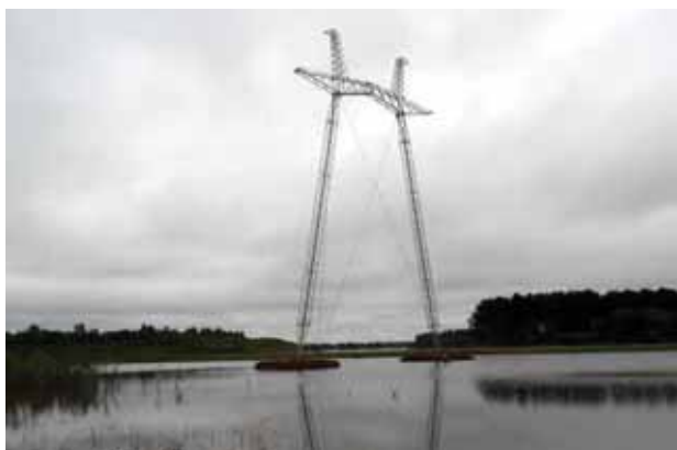
Строительство ВЛ 500 кВ Богучанская ГЭС-Озерная
