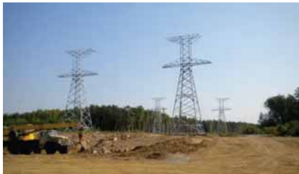
Реконструкция вл 220 кВ Белоярская АЭС - Окунево (заходы на Белоярскую АЭС-2)
